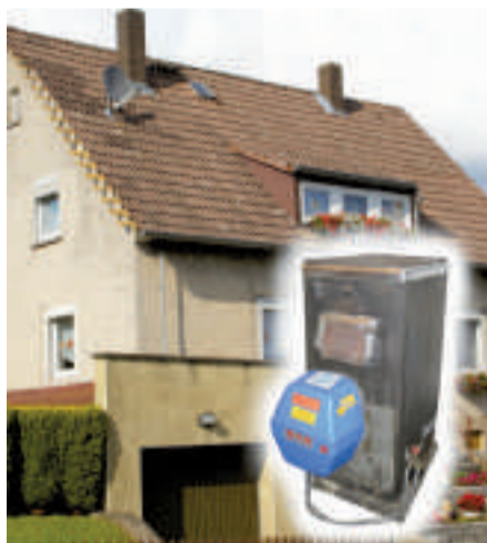
Unisoliertes Haus Alter Ölkessel Jahresverbrauch: 22 Liter/m 2
