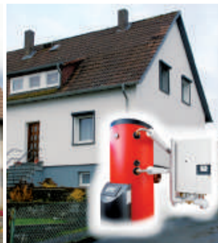
Isoliertes Haus Neuer Ölbrennwertkessel Jahresverbrauch: 7 Liter/m 2
