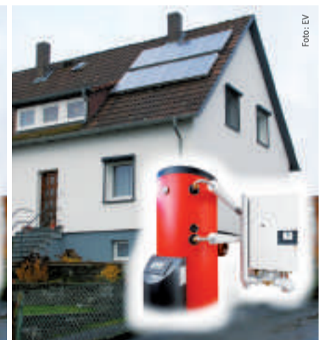
Isoliertes Haus Neuer Ölbrennwertkessel/Solaranlage Jahresverbrauch: 5 Liter/m 2
