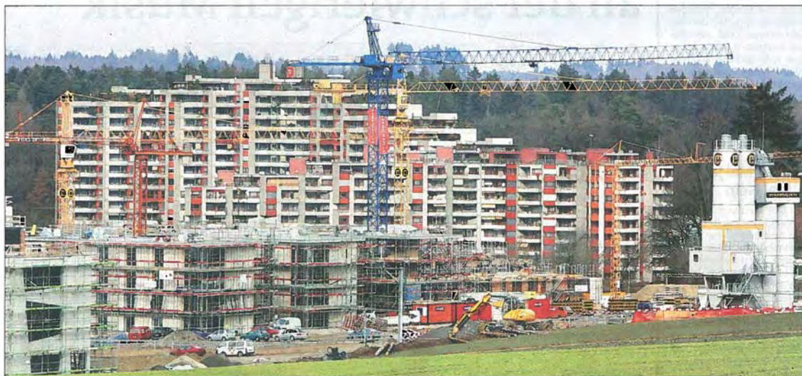
Wohnungsbau-Offensive: In Brünnen entsteht gegenwärtig ein neues Stadtquartier. Es soll nicht das einzige bleiben.
