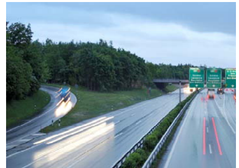
Überdeckung der Autobahn
