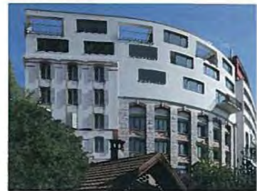
Loftgebäude/lofts «Crêt-Taconnet», Neuenburg/Neuchâtel; Realisierung in Eigenregie/Réalisation comme architecture et maître d'ouvrage
